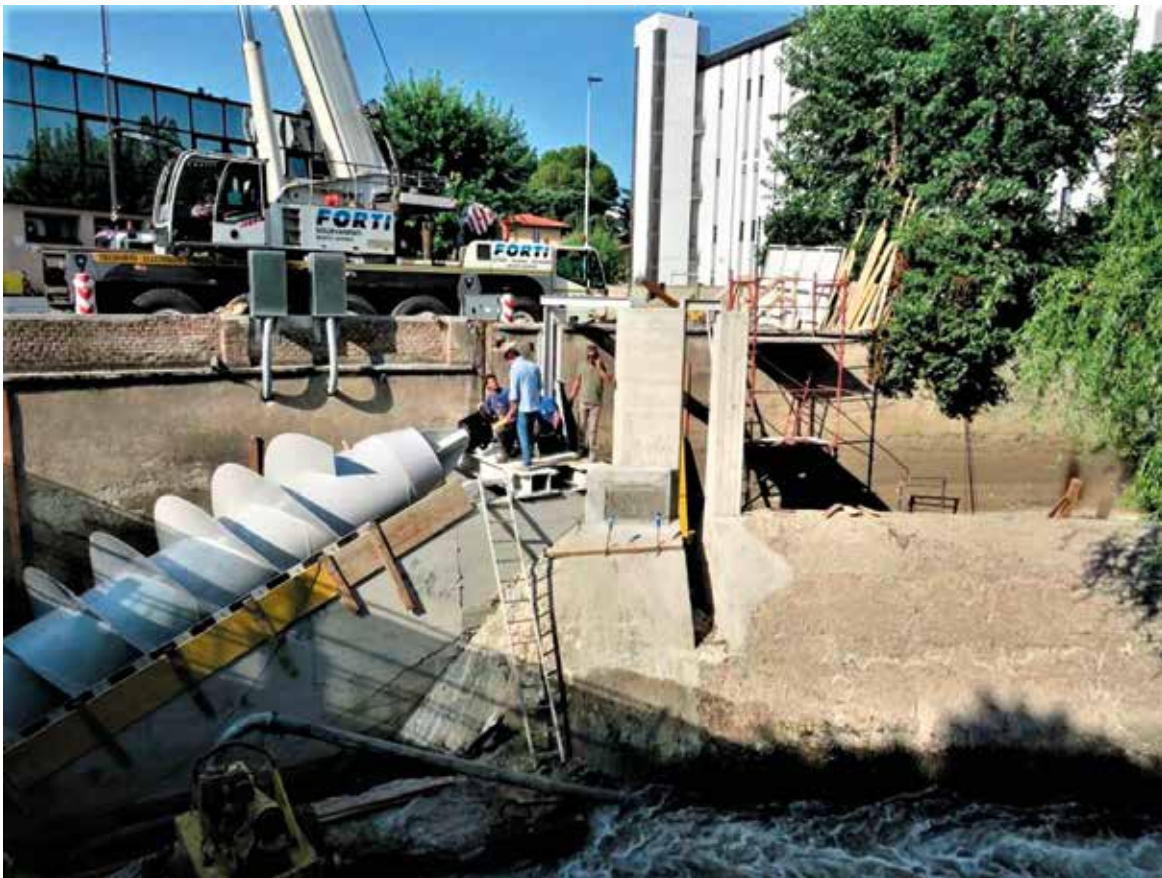
Posizionamento della coclea sulla diga Mazzocchi
