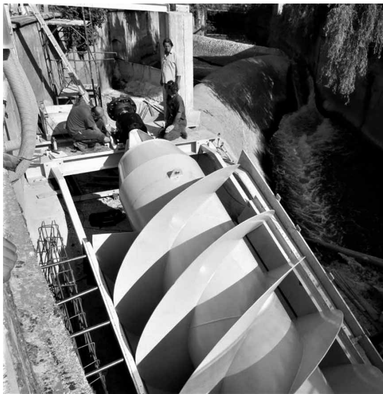
Primo piano dell'impianto
