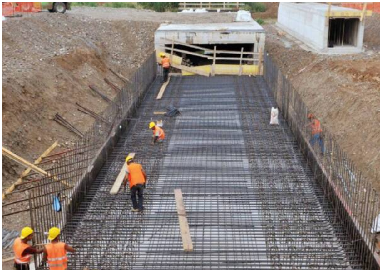
Cantiere di Pedemontana, foto bergamonews.it
